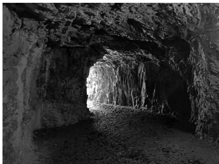
Höhlengänge in Sabotin als Versorgungswege...
